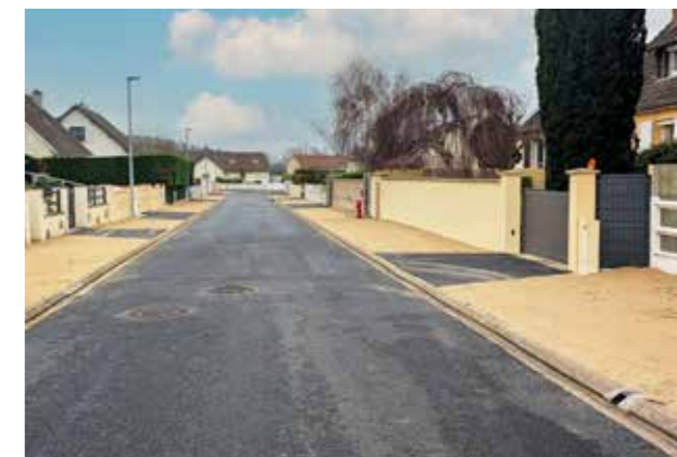
Réfection des trottoirs de la rue de la Vallée Braize.
